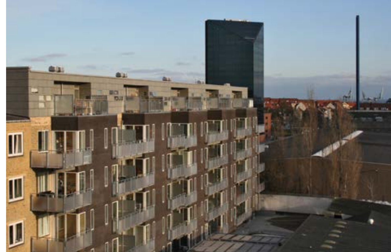
Afd. 4 på Silkeborgvej fra 1945 blev ført ind i det nye årtusind med en omfattende renovering i 2006.
