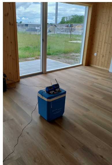
Målestation i det færdige byggeri
